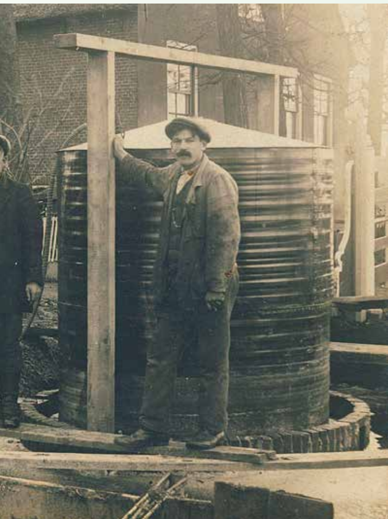
1914 een brongasinstallatie bouwen.
