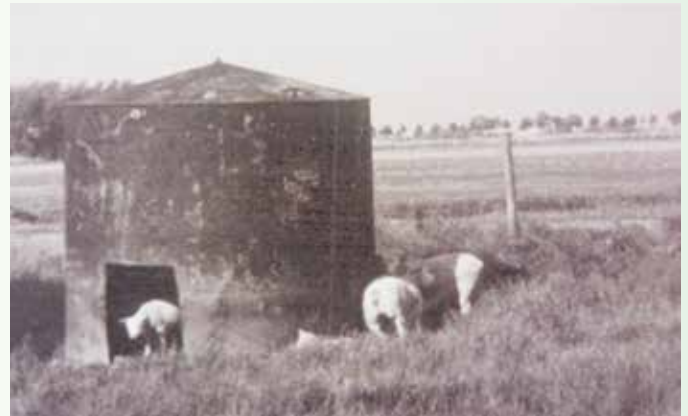
De oude gasketels werden vaak als schuilplaats gebruikt voor schapen en varkens.
