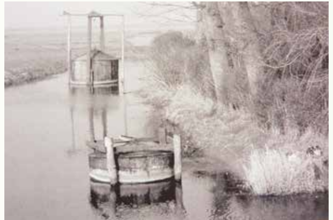
Brongasinstallatie met bronput en voorraadtank in de sloot.
